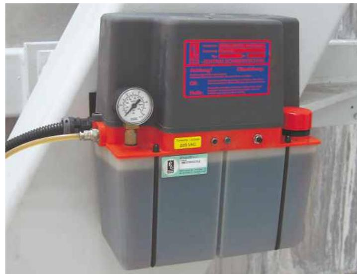
Elettropompa per impianto centralizzato di lubrificazione automatica
